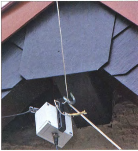
Bild 3: Am Giebel ist ein Schaukelhaken verankert, der das Hochziehen, Spannen sowie Herablassen von Drahtantennen mittels dünner zugfester Seile ermöglicht.
