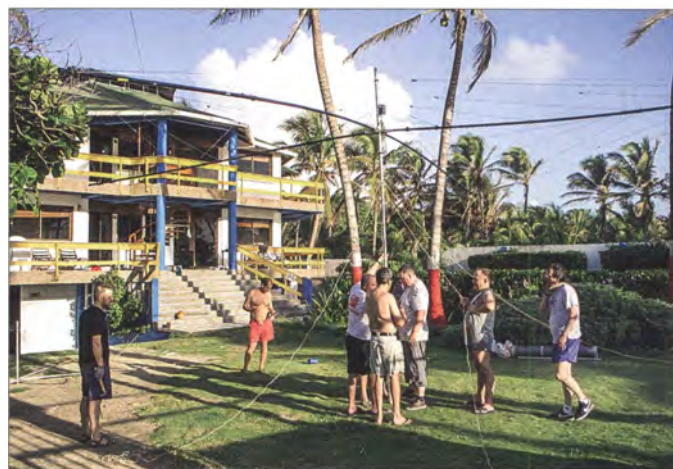
Echtes Teamwork: Installation eines Spiderbeams auf dem Gelände der Anlage des „Red Crab Inn“
